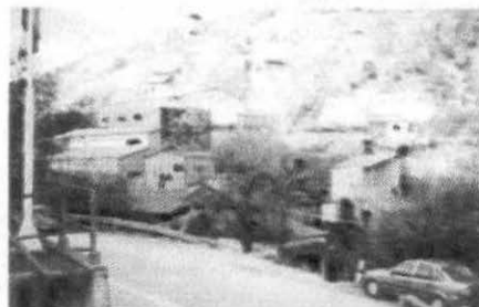
φωτ. 1. Οι εγκαταστάσεις εμπλουτισμού στο 25ο χλμ. Δράμας-Νευροκοπίου photo. 1. The mill at the 25 th km of the Drama-Nevrokopi road
