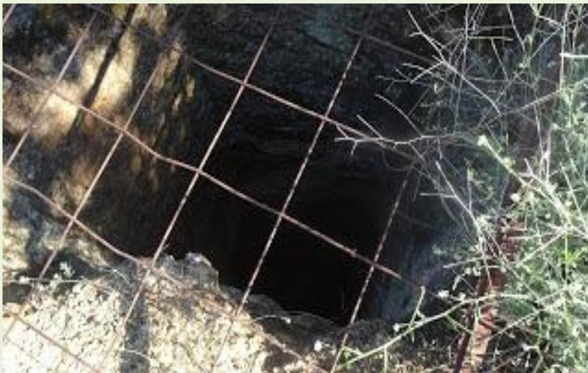
Εικ.5 Ερευνητικό φρέαρ, 20 περίπου μέτρων, το οποίο χρήζει περαιτέρω μέτρων προστασίας των ανυποψίαστων περιπατητών!
