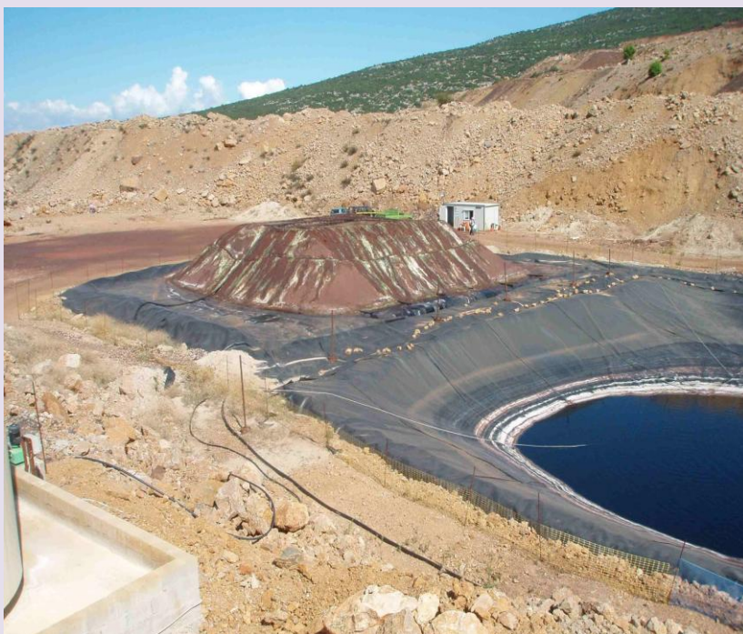
Εικ . Πιλοτικό υδρομεταλλουργικό πρόγραμμα εκχύλισης λατεριτών σε σωρούς
