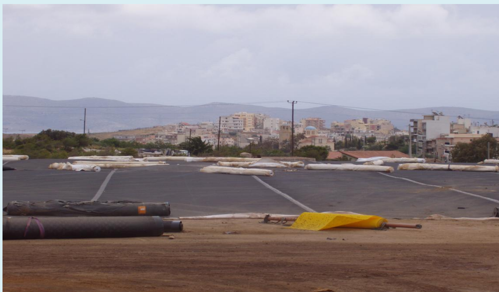
Φωτ. 6 Απορρύπανση με τη μέθοδο ΥΤΡΕ, στη διάρκεια τοποθέτησης της μεμβράνης απομόνωσης.
