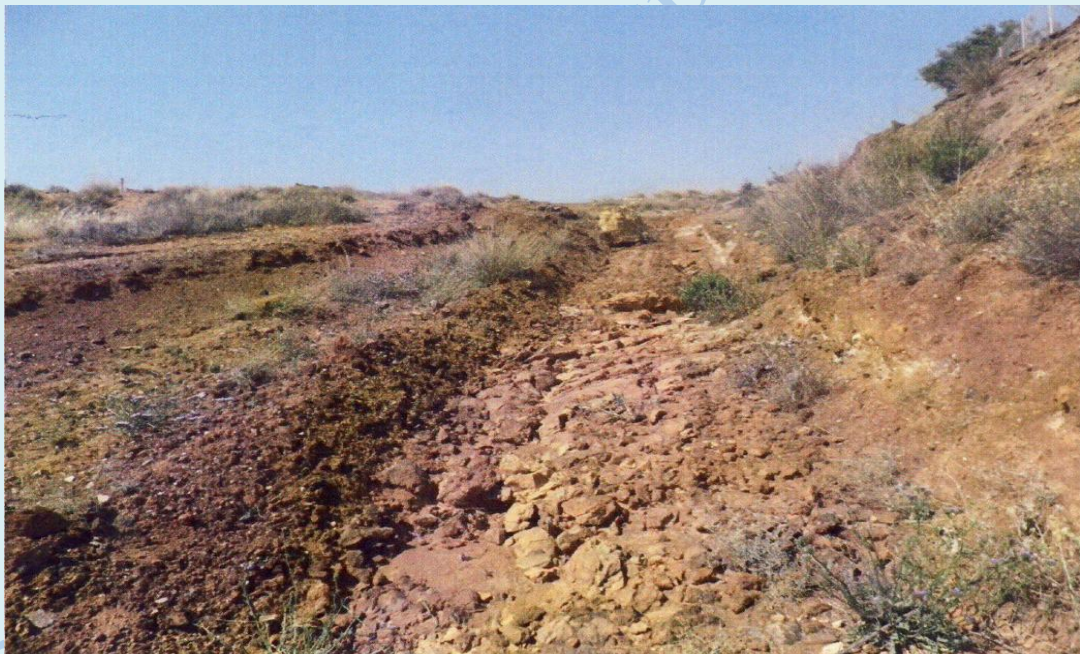
Φωτ. 5. Καταστροφή του έργου απορρύπανσης από την έλλειψη αποστραγγιστικών έργων.
