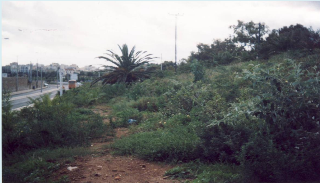
Φωτ. 1 Πετυχημένη βλάστηση σε πρανές με φυτική γη και σπορά.
