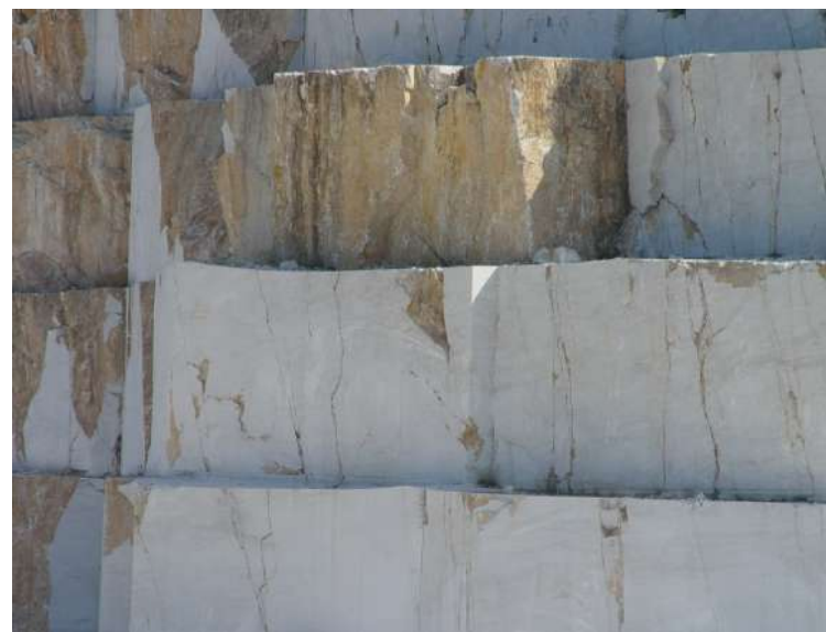
Εικόνα 3: Κοντινή άποψη μετώπου εξόρυξης σε ενεργό λατομείο στα Κομνηνά (επίσκεψη Ι.Γ.Μ.Ε., 2014).
