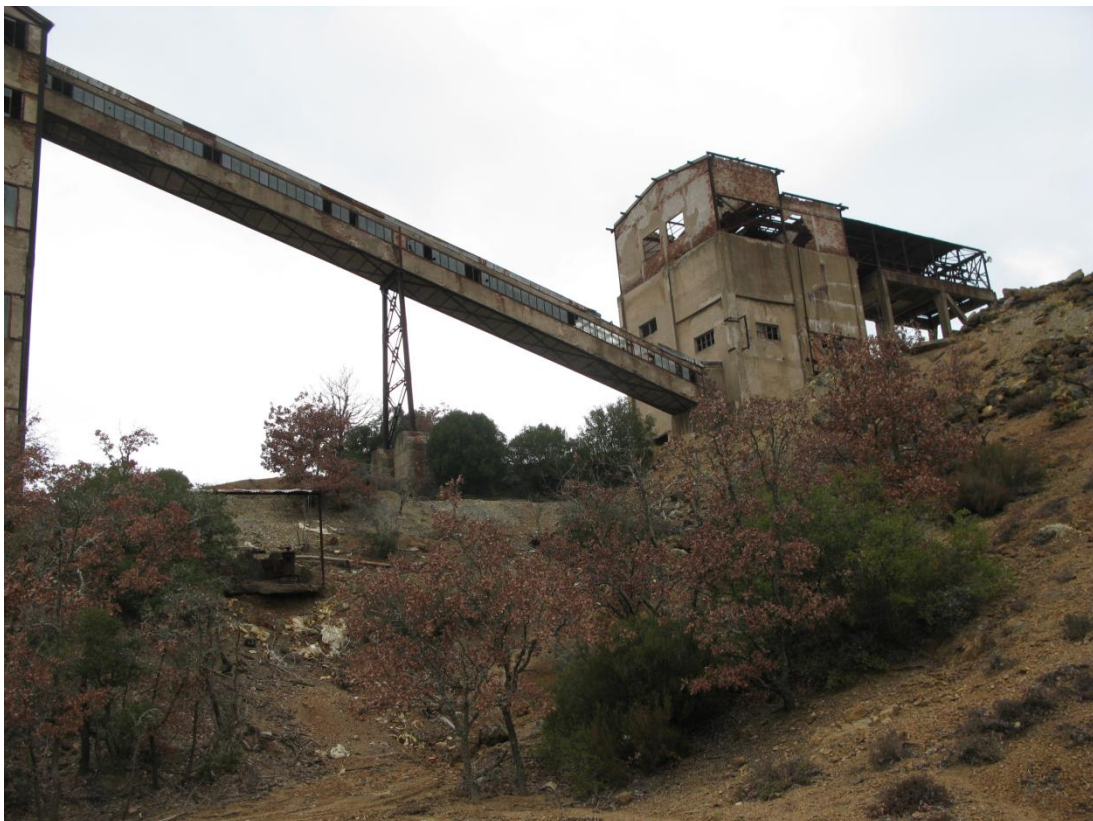
Εικόνα 1: Εγκατάσταση εμπλουτισμού στο Μεταλλείο Κίρκης
