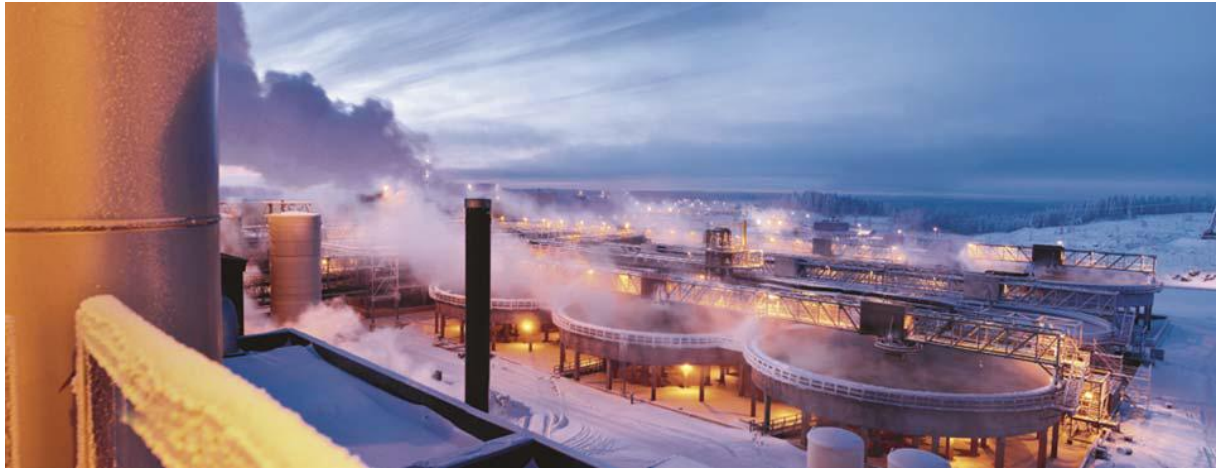
Εικόνα 12: Μεταλλείο Talvivaara , Φινλανδία ( πιλοτική και βιομηχανική λειτουργία βιο-εκχύλισης σε σωρούς στους -20 °C)
