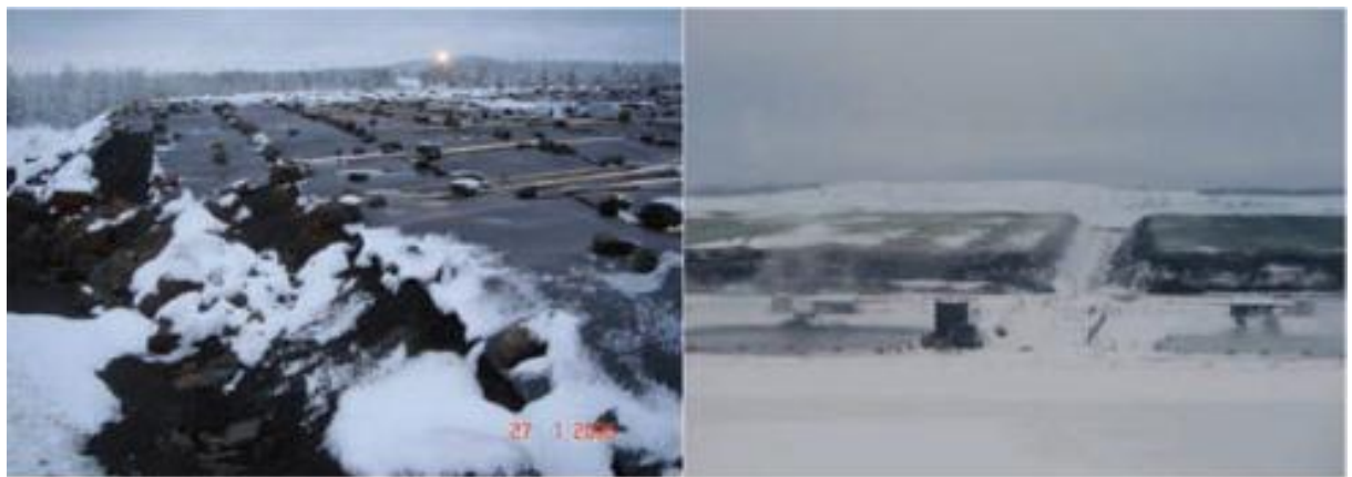
Εικόνα 13: Μεταλλείο Talvivaara , Φινλανδία ( πιλοτική και βιομηχανική λειτουργία βιο-εκχύλισης σε σωρούς στους -20 0C)
