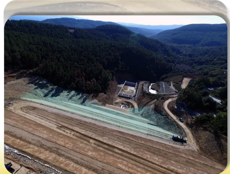
Kokkinolakkas TMF dam construction
