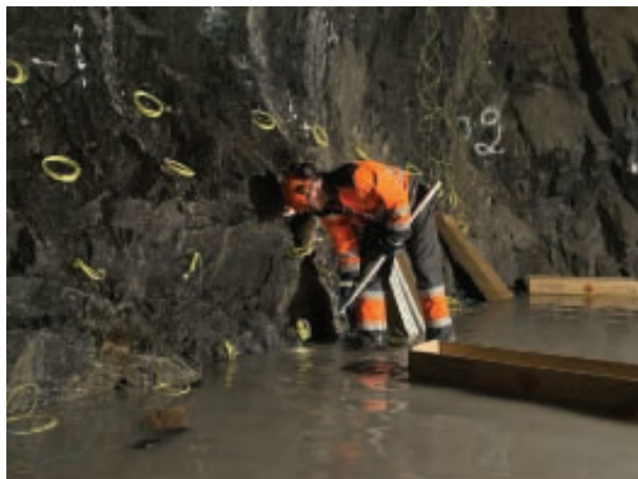
Εργασίες γόμωσης σε μέτωπο οδικής σήραγγας (Tampere Finland) Πηγή : http://www.yle.fi
