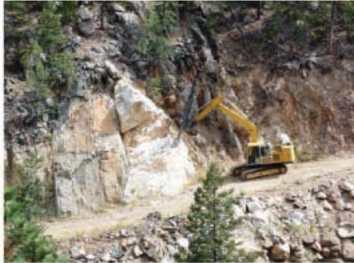
Διατρήση σε δυσπρόσιτη περιοχή. Πηγή www.hardrockblasting.com
