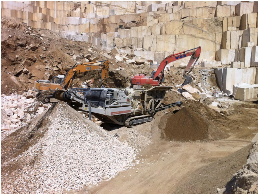
Φωτ.7: Διαχωρισμός μη ρυπανθέντος χώματος από στείρα υλικά.
