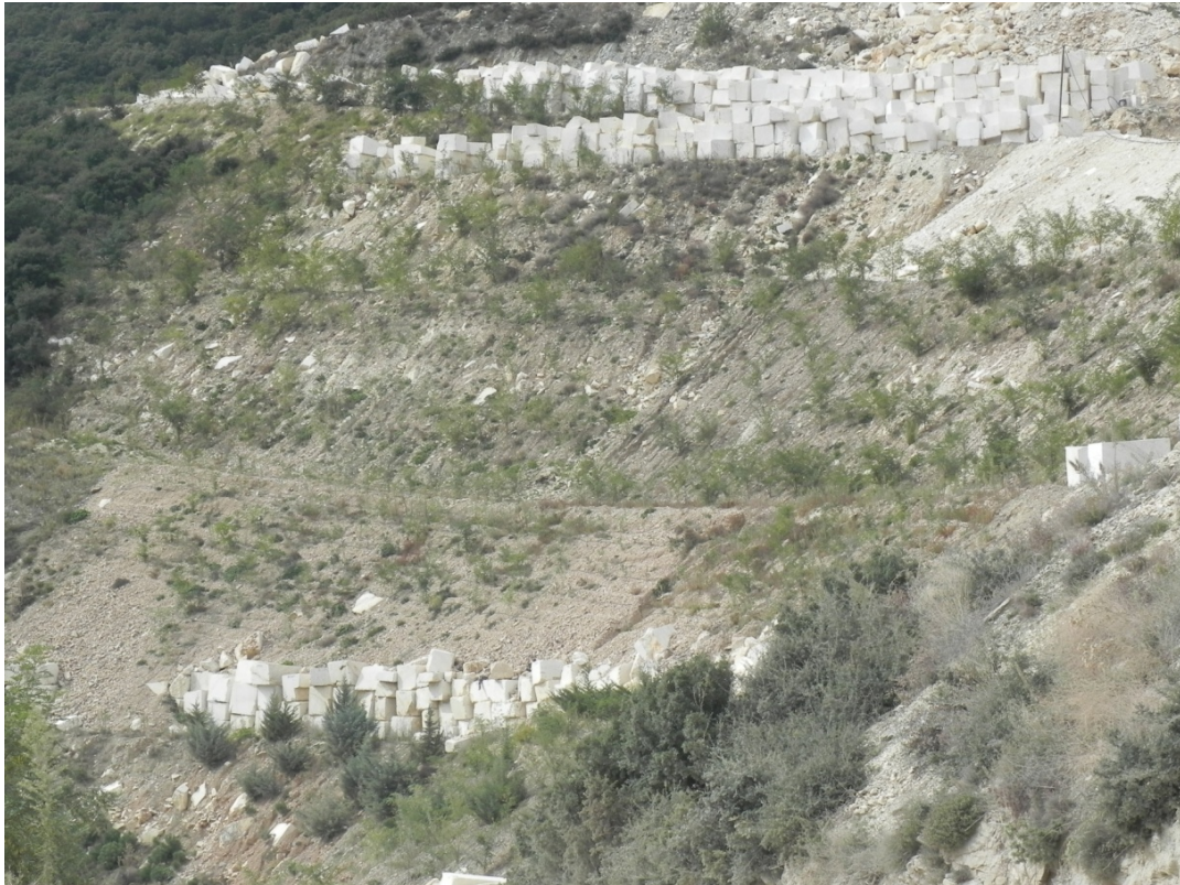
Φωτ. 6: Αποκατεστημένες βαθμίδες απόθεσης στείρων (στάδιο συντήρησης).
