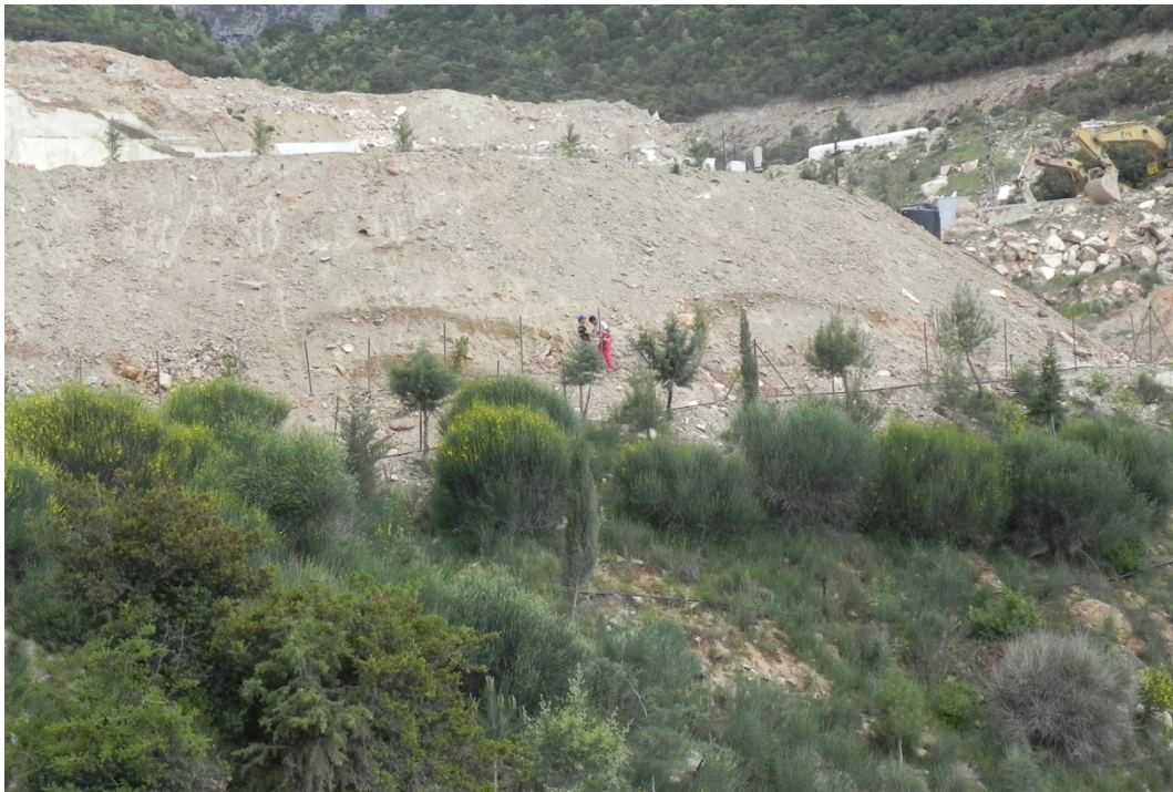
Φωτ. 11: Αποκατάσταση χαμηλότερης βαθμίδας–Διάνοιξη λάκκων στην ανώτερη
