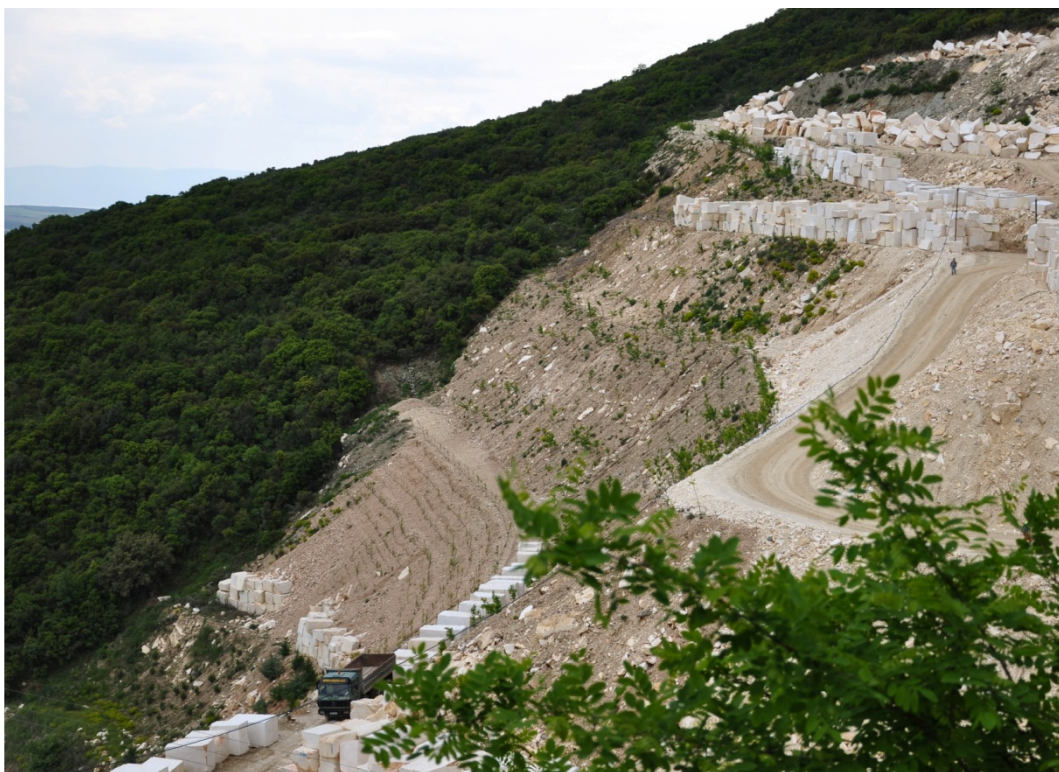
Φωτ. 5: Αποκατεστημένες βαθμίδες απόθεσης στείρων (στάδιο φυτεύσεων).
