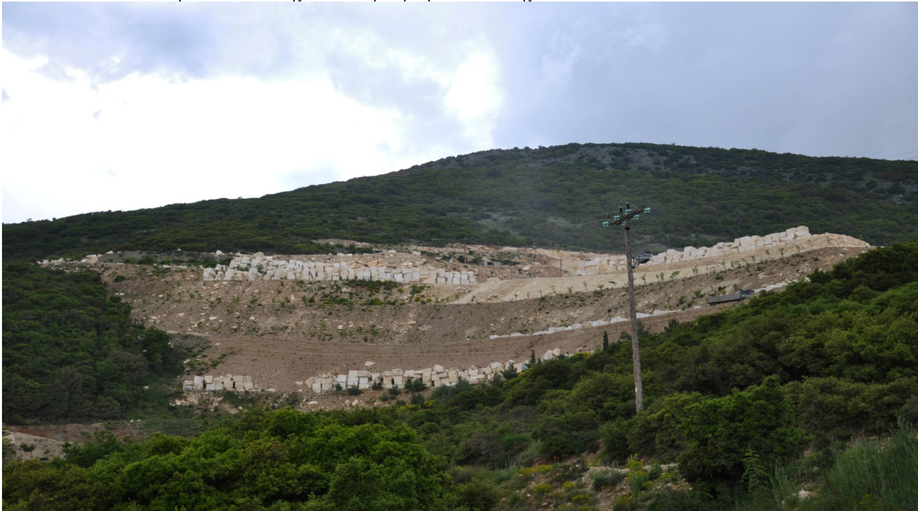
Φωτ. 12: Οπτικό αποτέλεσμα αποκατάστασης των τεσσάρων βαθμίδων απόθεσης.
