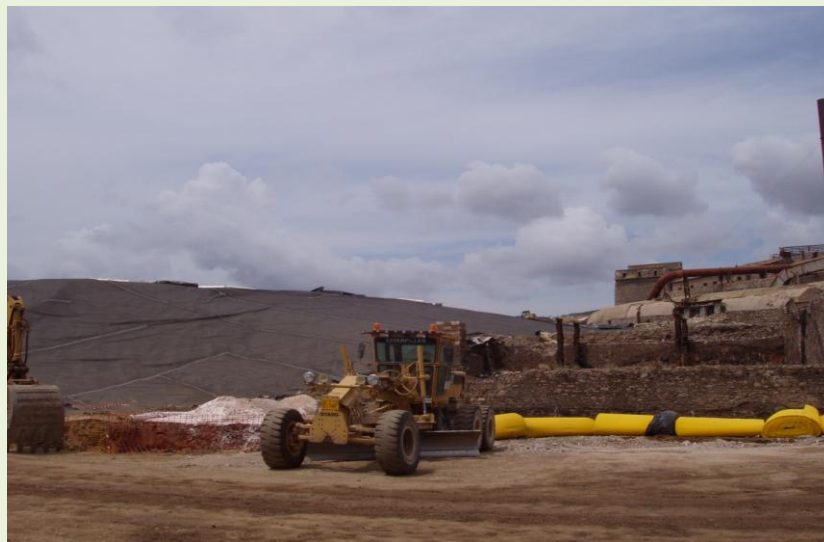
Φωτ.5. Εξυγίανση με ταφή των ρυπασμένων εδαφών (YTPE). Εργασίες για την επικάλυψη του συγκεντρωμένου ρυπασμένου υλικού από το Πάρκο.
