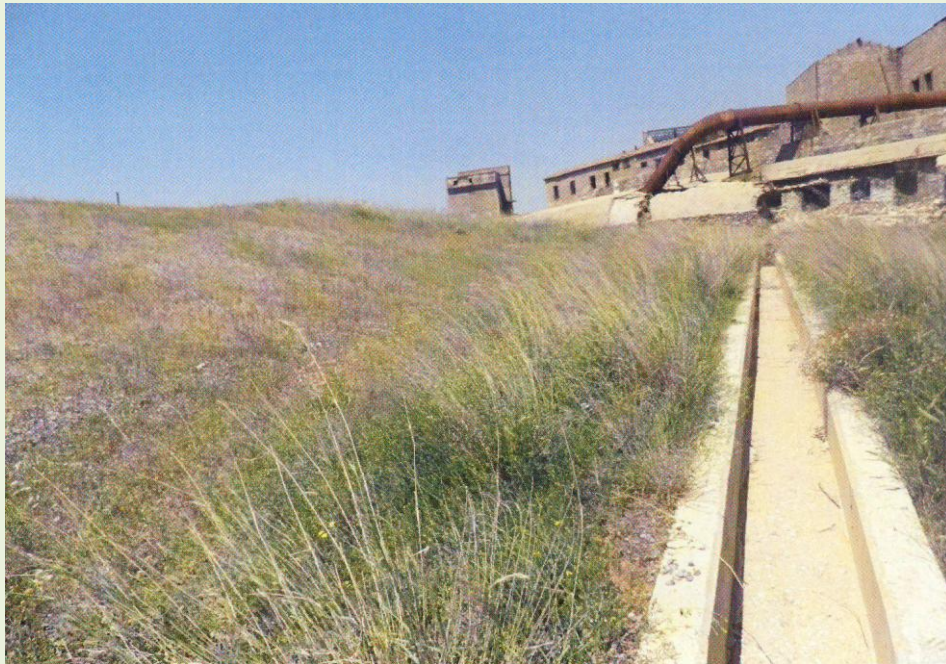
Φωτ.7 Τα μόνιμα αποστραγγιστικά έργα προστάτεψαν το έργο της απορρύπανσης
