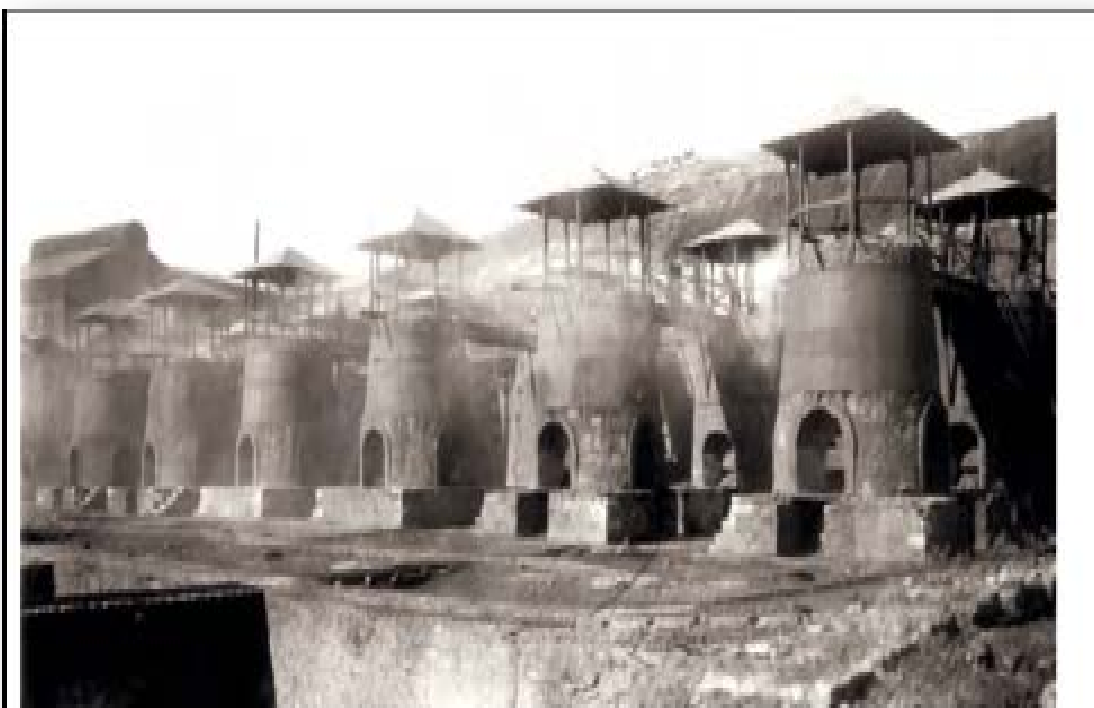
Γαλήνη Επαρσία Μισοθηνίων Λαυρίου: μαθητευγική εγκατάσταση παραγωγής συμπυκνωμάτων μεθόδου ψευδαργύρου (χλωταργείο κλασική)
