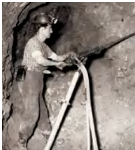
■ «ΑΕ ΜΥΚΟΜΠΑΡ». Εξόρυξη υπόγειας στοάς
