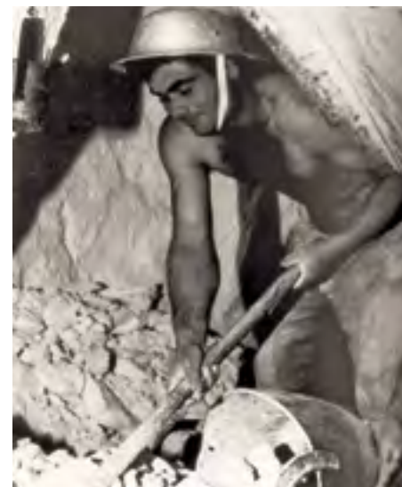
■ Υπόγεια εκμετάλλευση κοαλίτη στη Μήλο. Μπαζαδόρος δουλεύει «τσάπα κόφα», για φόρτωση του προϊόντος σε βαγόνια. Η εκμετάλλευση κοαλίτη στη Μήλο πραγματοποιήθηκε από πολλές μικρές και μεγάλες εταιρείες της εποχής της δεκαετίας 1950 και 1960, φτάνοντας τους 70.000 τόνους κατά μέσον όρο ανά έτος. (φωτογραφία από το αρχείο του βιβλίου «Η ιστορία του κοαλίτη της Μήλου» του Γ. Ξυδούς και Λ. Παρασκευαΐδη)
