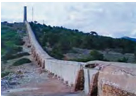
■ Κεντρικός καπναγωγός των εγκαταστάσεων φρύξης της Μεταλλουργίας Λαυρίου στη θέση Κυπριανό
