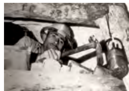
■ Δεκαετία 1960. Ξυλοδεσιά σε υπόγεια στοά. (φωτογραφία αρχείου από το βιβλίο «Η ιστορία του κοαλίτη της Μήλου» του Γ. Ξυδούς και Λ. Παρασκευαΐδη)
