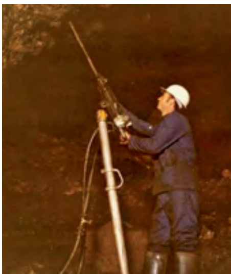
■ Διάτρηση με αερόσφυρα σε υπόγεια εκμετάλλευση βωξίτη. Φωτογραφία τέλη δεκαετίας '60 (αρχείο ΕΛΜΙΝ)
