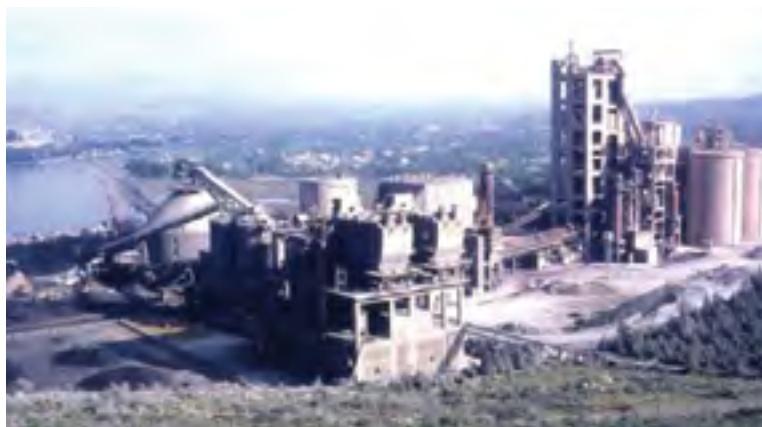
■ Εργοστάσιο «ΗΡΑΚΛΗΣ» στο Μηλάκι Ευβοίας.
