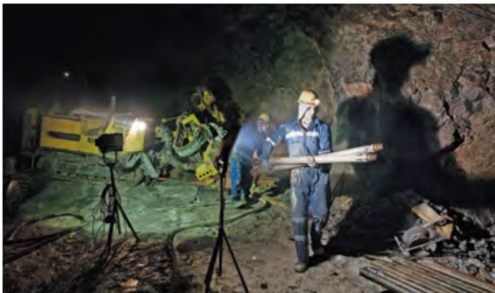
■ ΕΛΜΙΝ. Υπόγειο εργοτάξιο Βωξίτη
