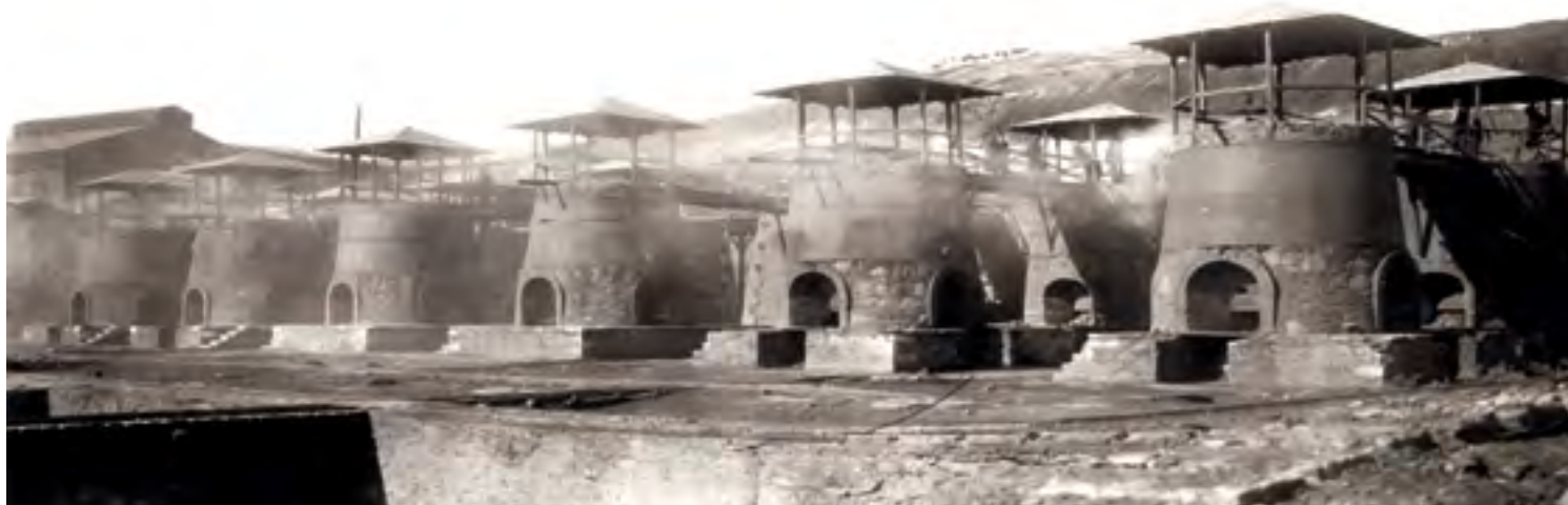
■ Γαλλική Εταιρεία Μεταλλείων Λαυρίου: μεταλλουργικές εγκαταστάσεις παραγωγής συμπυκνωμάτων μολύβδου ψευδαργύρου (φωτογραφία εποχής)
