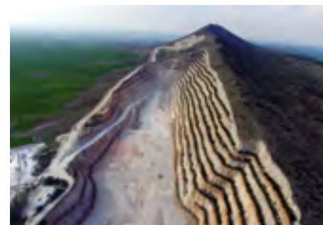
■ Λατομείο αδρανών «Δρυμός» της «TITAN ΑΕ»
