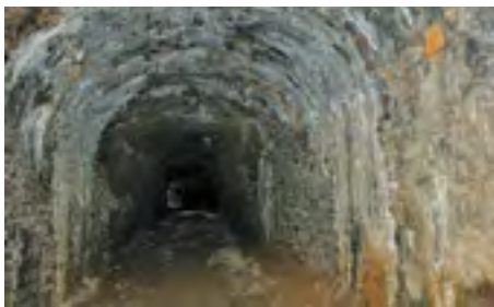
■ Σήραγγα Καμάριζας Γαλλικής Εταιρείας Μεταλλείων Λαυρίου
