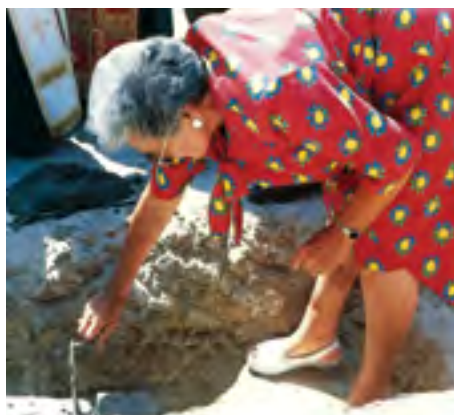
■ Καίτη Κυριακοπούλου. Θεμελίωση του Μεταλλευτικού Μουσείου της Μήλου (φωτογραφία από Ιστορικό Λεύκωμα της S&B για τα 70 χρόνια του Ομίλου)
