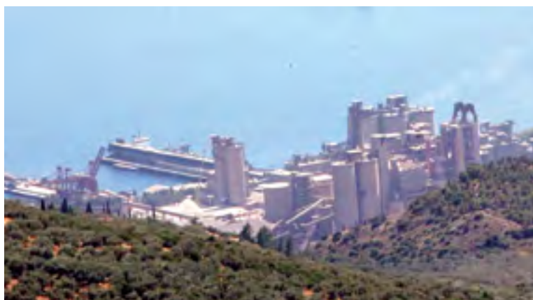
■ Τέλη δεκαετίας 1990. Εργοστάσιο της εταιρείας ΑΓΕΤ στο Βόλο
