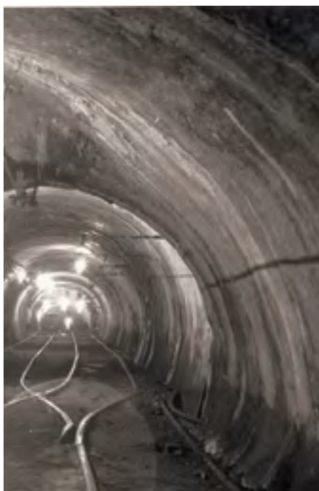
■ Υπόγεια στοά στο Αλιβέρι (φωτογραφία αρχείου ΔΕΗ/λευκωμα «Εξορύσσοντας το φως, μνήμες και εικόνες από λιγνίτη»)
