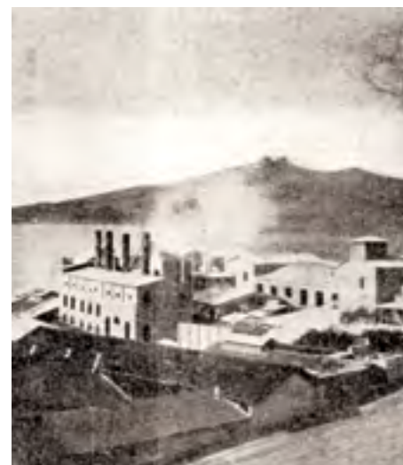
■ 1925. Εργοστάσιο ΤΙΤΑΝ στην Ελευσίνα
