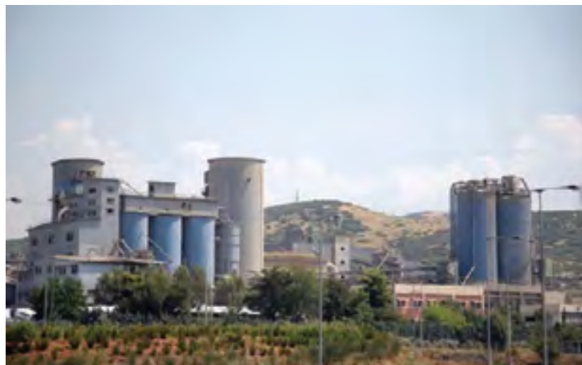
■ Εργοστάσιο Ομίλου TITAN, στο Καμάρι Βοιωτίας
