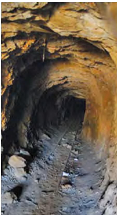
■ Σέρφικος, Μεγάλο Λιβάδι, μεταλλεία Εταιρείας Σερύφου Σπηλιαζέζας: υπόγεια στοά
