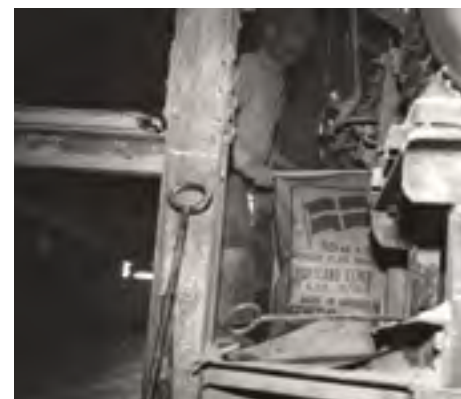
■ Αρχές δεκαετίας 1950. Σάκευση στο εργοστάσιο τσιμέντου της ΑΓΕΤ στη Δραπετσώνα
