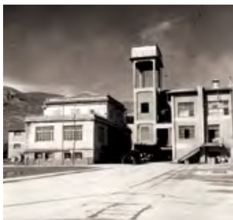
■ Δεκαετία '60. Άποψη των γραφείων του εργοστασίου της «ΑΓΕΤ» στο Βόλο
