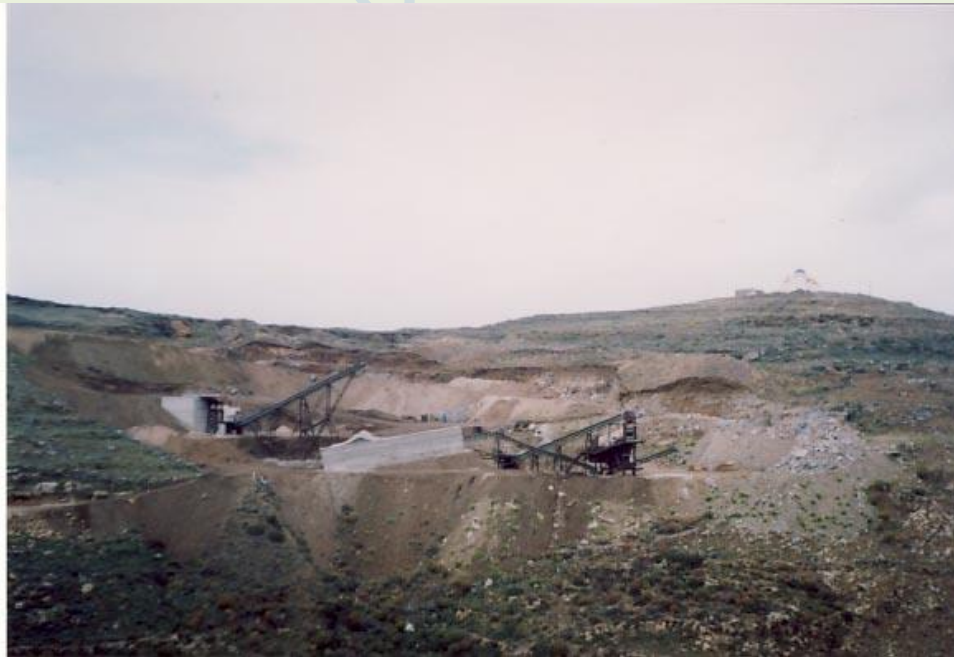
Φωτ.2 Μια άποψη της εγκατάστασης που πραγματοποιήθηκε με διαφορετική σχεδίαση και σ' άλλη θέση από εκείνη της ΕΛΕΒΜΕ (εγκαταλειμμένη σήμερα).
