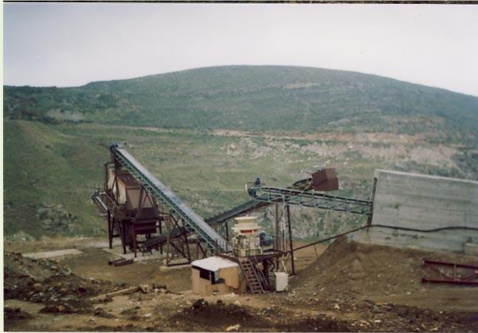
Φωτ.3. Άλλη άποψη της εγκατάστασης για την παραγωγή συγκεκριμένου αντιολισθητικού αδρανούς, με προδιαγραφές!!
