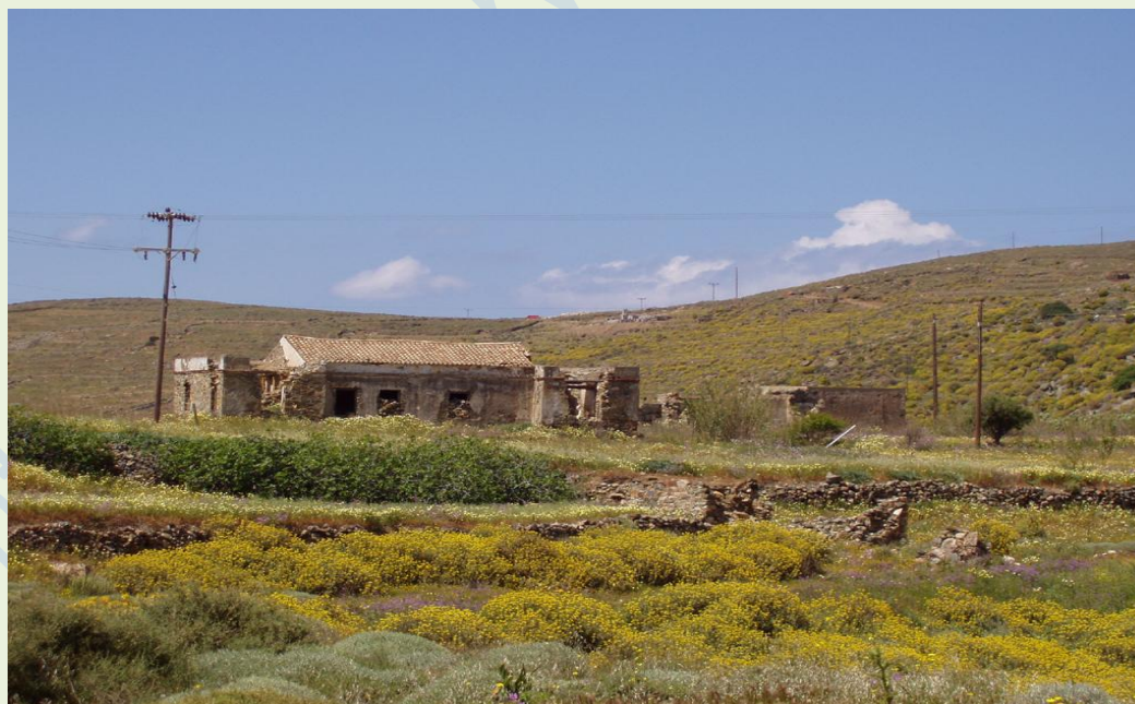
Φωτ.5. Το ερειπωμένο παλιό Νοσοκομείο του Γρώμαν.
