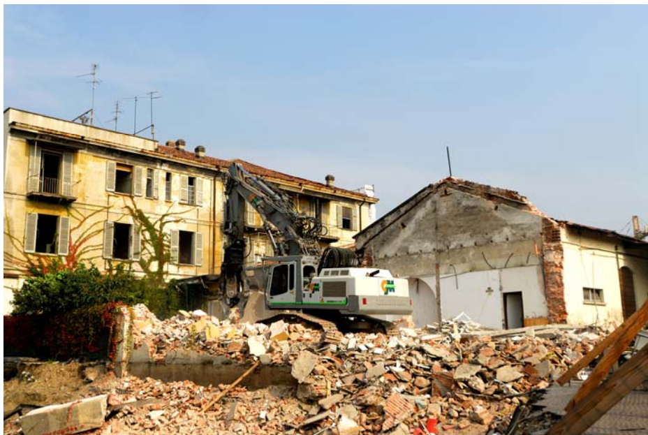
Εικόνα 1.1: Παραγωγή αποβλήτων από κατασκευές και κατεδαφίσεις, Μιλάνο-Ιταλία (ANPAR, 2006).
