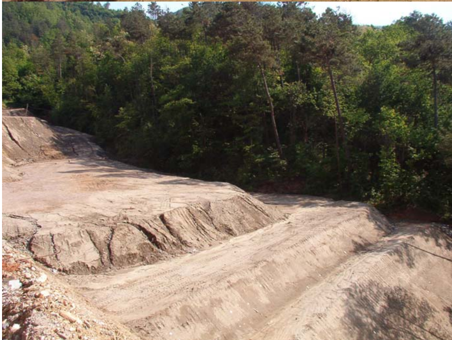
Εικόνα 4.3: Χρήση ανακυκλωμένων αδρανών σε έργο περιβαλλοντικής αποκατάστασης (ANPAR, 2005).
